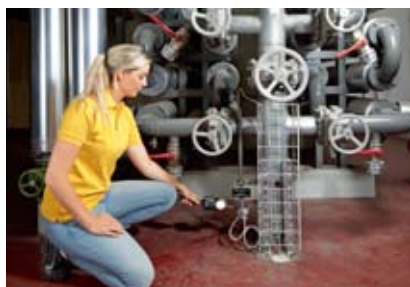
1 Verifica del conduttore di protezione
