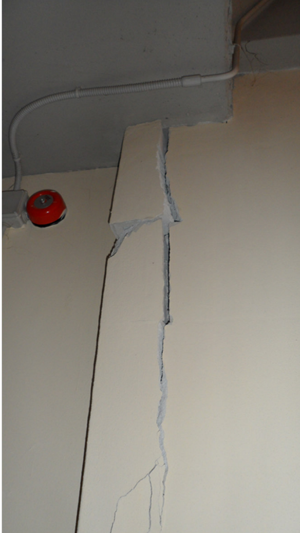
Distacco di intonaco
