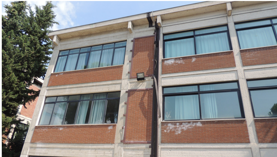
Sistemi antiribaltamento di pannelli di tamponatura
