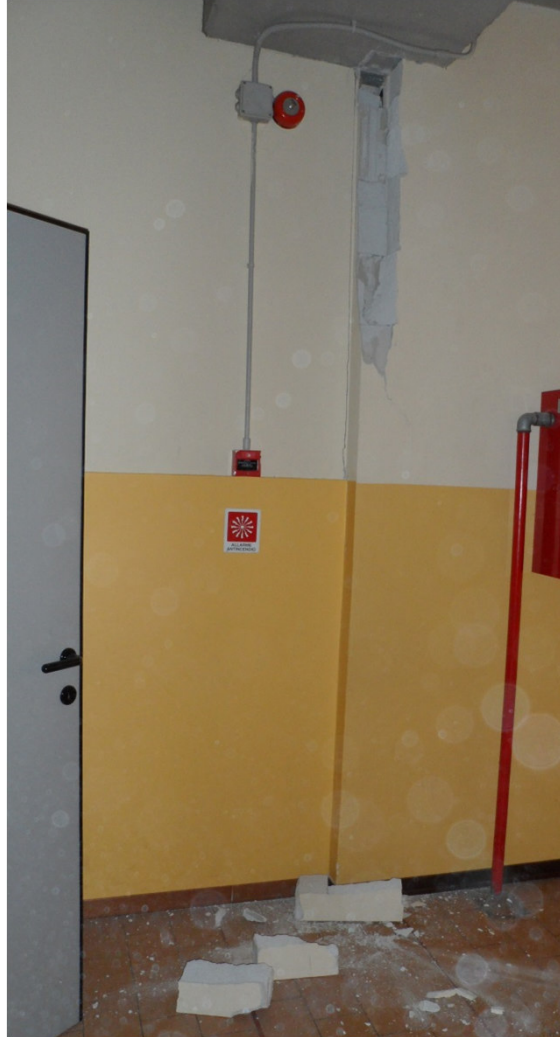
Distacco di intonaco
