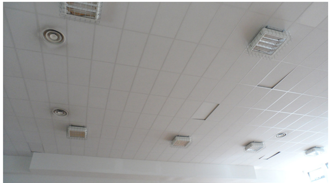
Spostamento dei pannelli di controsoffitto
